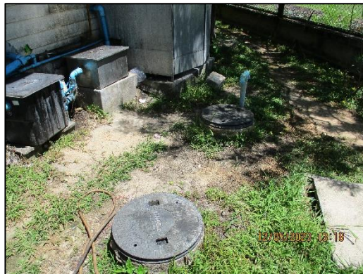
ภาพถ่ายที่ 2.2-3 ระบบบำบัดน้ำเสียสำเร็จรูป
