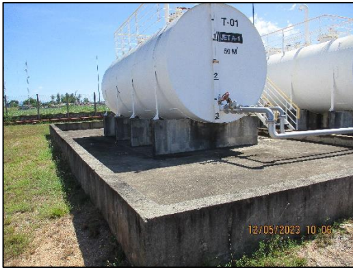
ภาพถ่ายที่ 2.2-25 คั่นกำแพงคอนกรีตป้องกันน้ำมันรั่วไหล
