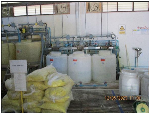
ภาพถ่ายที่ 2.2-36 ถังเคมีคลอรีนฆ่าเชื้อโรค
